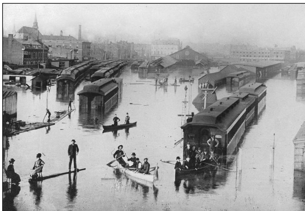
Inondations à la Gare Bonaventure, 1886
